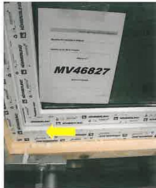
Zona filtración de agua
