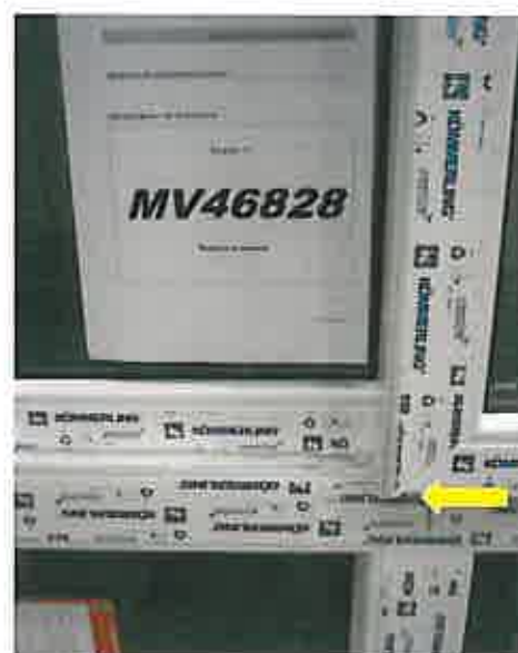
Zona filtración de agua
